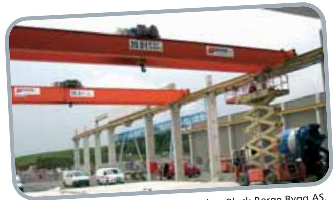
Bildet tatt under montasjen av kranene hos Block Berge Bygg AS.
